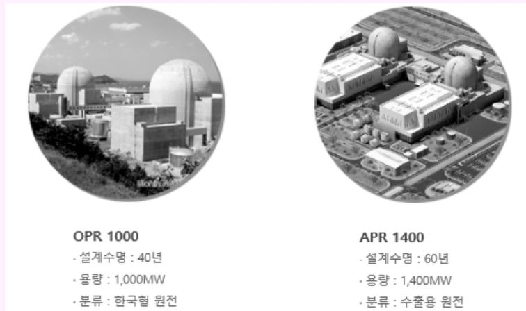
OPR1000은 1,000MW급 한국형 원전으로 51개월의 짧은 건설공기와 높은 경제성을 갖추고 있습니다. 1998년 울진 3호기에 적용되어 최초 건설된 이래 신고리 1,2호기 등에 적용되어 국제적으로 그 성능과 안전성이 입증되었습니다. APR1400은 OPR1000을 바탕으로 안전성과 경제성을 더욱 향상시킨 수출형 원전입니다. APR1400은 신고리 3,4호기에 적용되어 2007년 건설에 착수했으며 각각 2013년과 2014년에 준공될 예정입니다. UAE에도 동일한 모델이 적용되어 4기의 원전이 건설됩니다.
